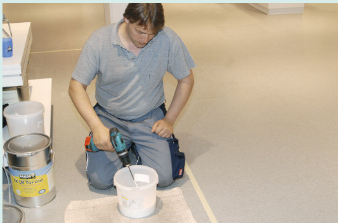
Matthias Schmidt beim Anrühren der Beschichtung für die ersten Teilflächen des PVC-Belags.
